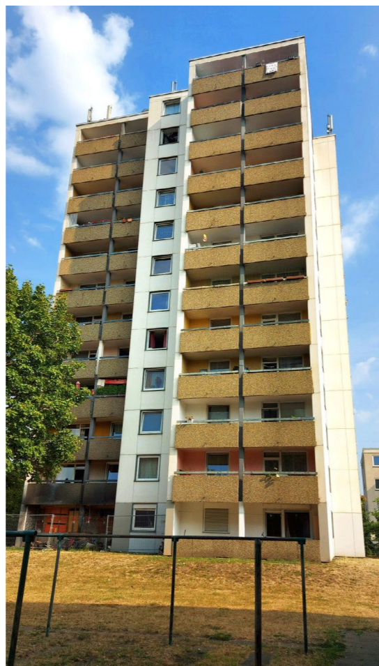
Bekommt eine neue Fassade: das Hochhaus in Koblenz
