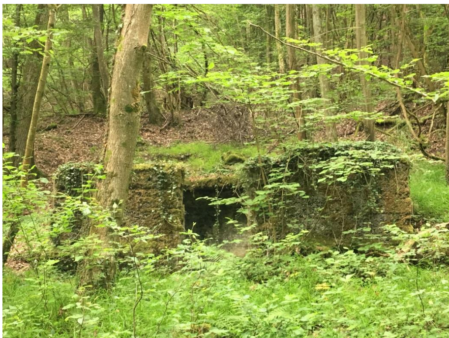
Abb. 39: Gebäudefundamente an der ehemaligen Baustelle am Tunnelportal Treis
