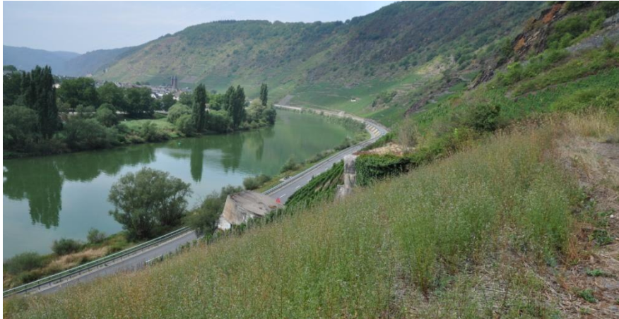
Abb. 25: Bunker im Hang am Tunneleingang Bruttig
