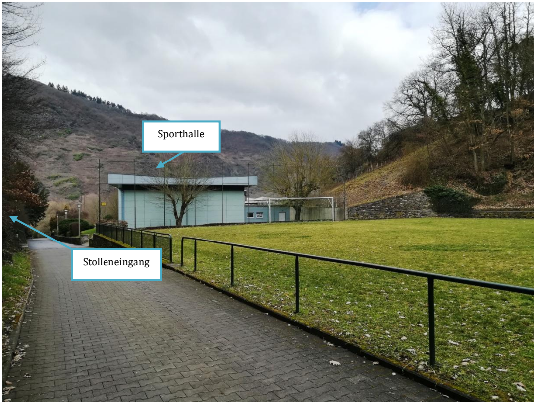
Abb. 13: Blick auf Sportplatz, Halle und Stolleneingang
