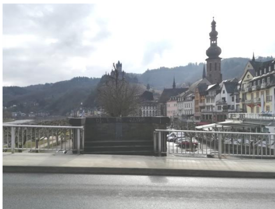
Abb. 8: Erker auf der Moselbrücke
