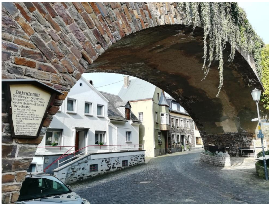
Abb. 18: Viadukt Ortsmitte Bruttig
