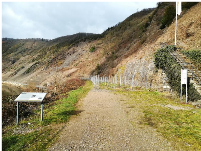
Abb. 27: Blick auf das Tunnelgelände Bruttig
