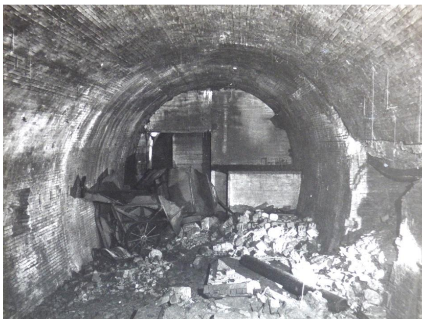
Abb. 24: Tunnelportal Bruttig, Eingang von innen gesehen (1980)
